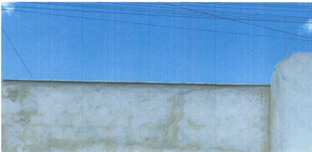
Foto 11 – Chapim de concreto pré-moldado
