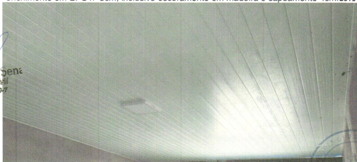
FOTO 07 - Laje pré-fabricada treliçada para piso ou cobertura, intereixo 38cm, h=12cm, el. enchimento em EPS h=8cm, inclusive escoramento em madeira e capeamento 4cm.2016
